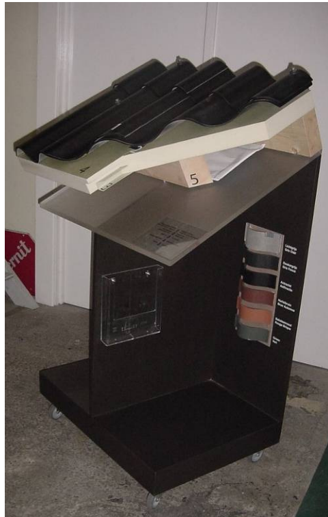
Foto 4: Golfplaat rechtstreeks op de isolatie
