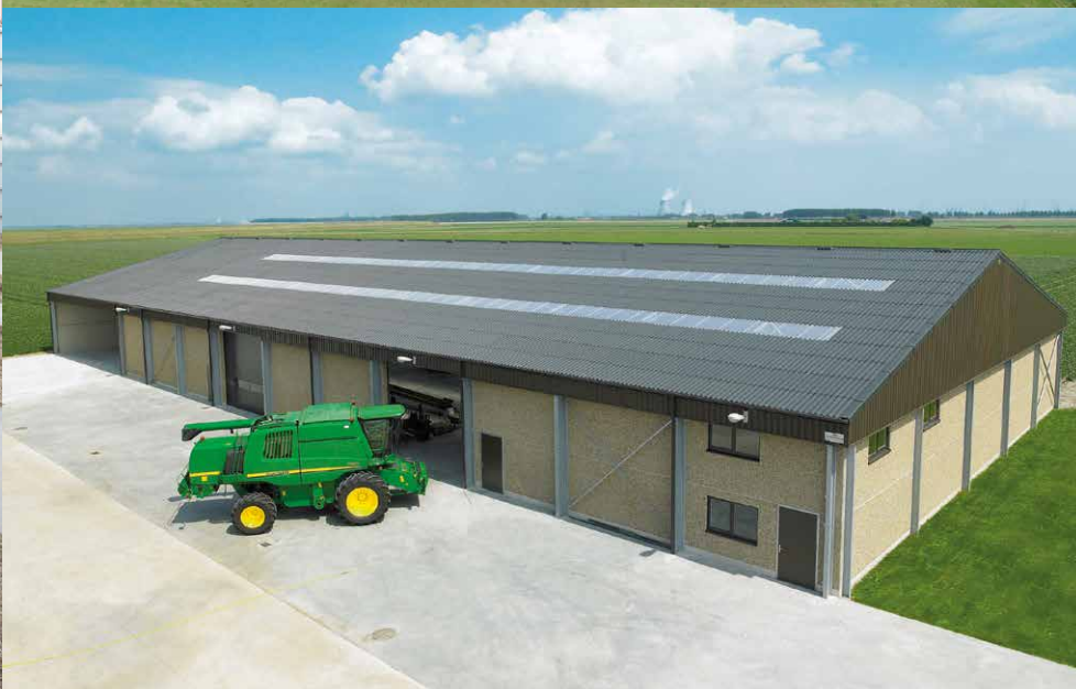
Loods voor gewassen
