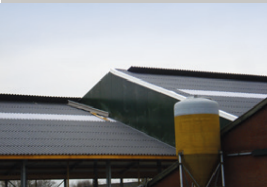
Ecolor doorsteeknok bevestigd met kalotten onder de bouten
